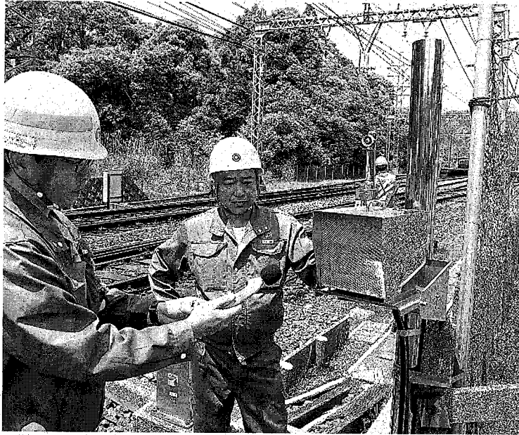
近鉄東青山駅付近の「シカ踏切」でユーソニックを検査する係員＝2017年5月、近鉄提供
